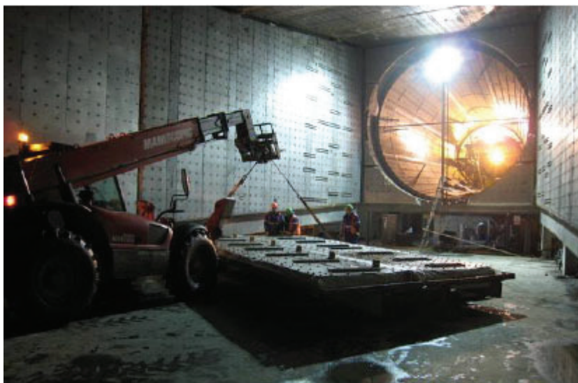
Figure 8: The HRSG inlet duct erection
