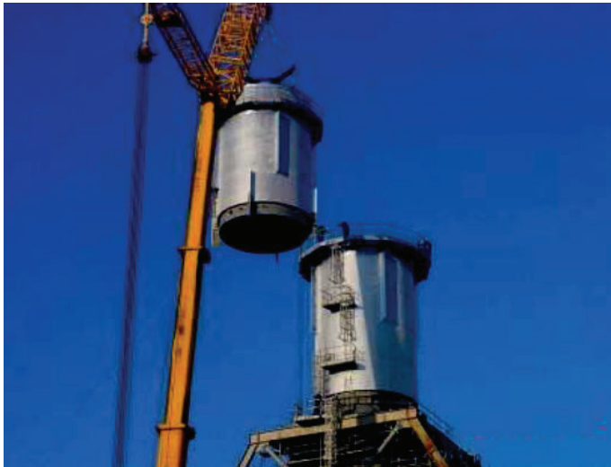
Figure 7: The HRSG upper part stack lifting
