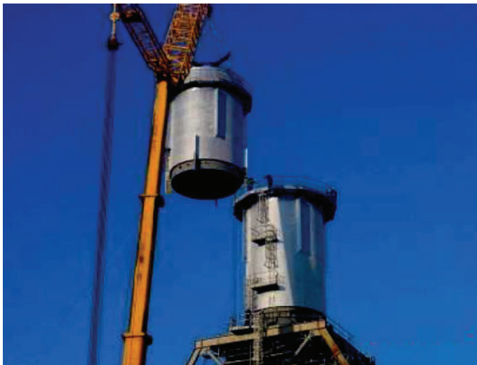
Figure 7: The HRSG upper part stack lifting
